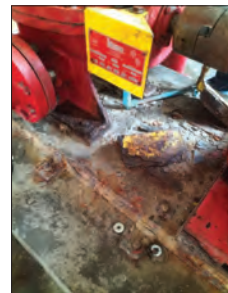
Photo 2.13 ฐานของเครื่องสูบน้ำดับเพลิงผุและเป็นสนิม (Not Normal)
