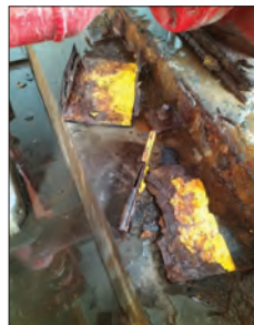
Photo 2.13 ฐานของเครื่องสูบน้ำดับเพลิงผุและเป็นสนิม (Not Normal)
